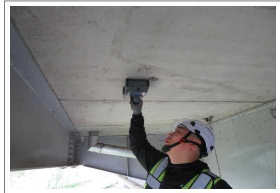
철근탐사 시험 전경 ①
