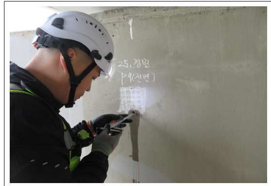
탄산화 잔여깊이 측정 전경 ②
