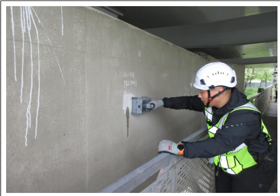
철근탐사 시험 전경 ②
