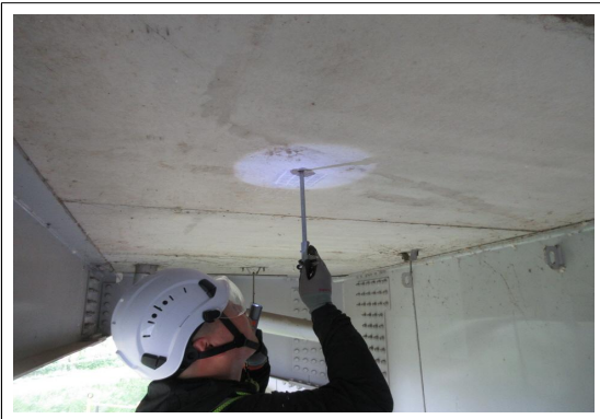
탄산화 잔여깊이 측정 전경 ①
